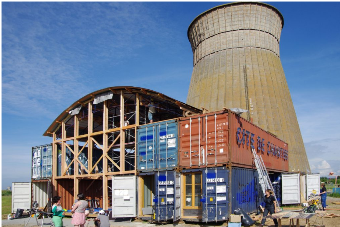
Au-delà d'une base de vie pour les ouvriers, la cité de chantier est un lieu ouvert à toutes et tous et le laboratoire à petite échelle du projet de réhabilitation de la Grande Halle voisine - © Le WIP
