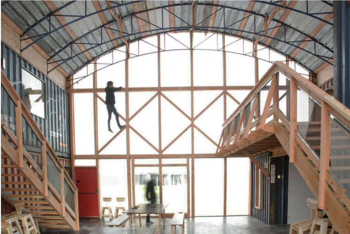
Des matériaux multiples, locaux, réutilisés pour construire la cité de chantier - © Collectif Etc
