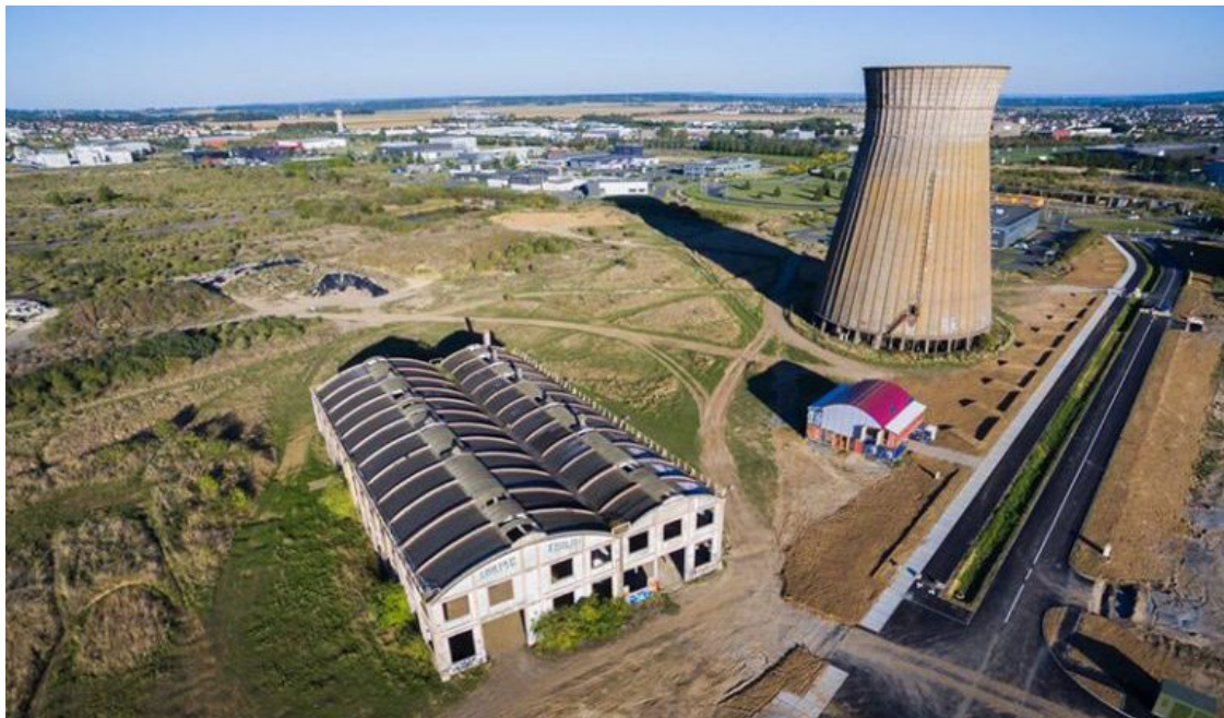
La cité de chantier entre la Grande Halle et le réfrigérant, derniers vestiges de l'industrie métallurgique à Colombelles © Damien Douche - Collectif Etc - 2018
