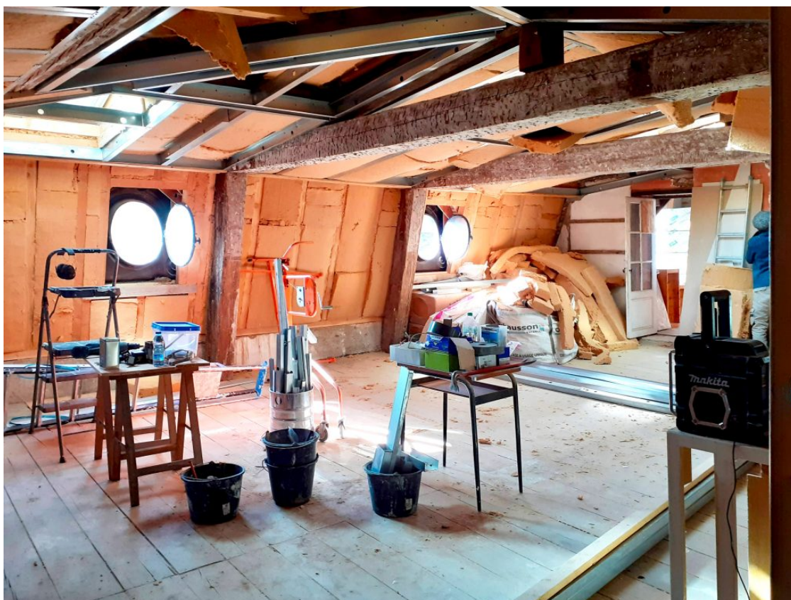
À L'Isle-Jourdain, travaux dans un appartement sous combles © Alter Habitat Lislois
