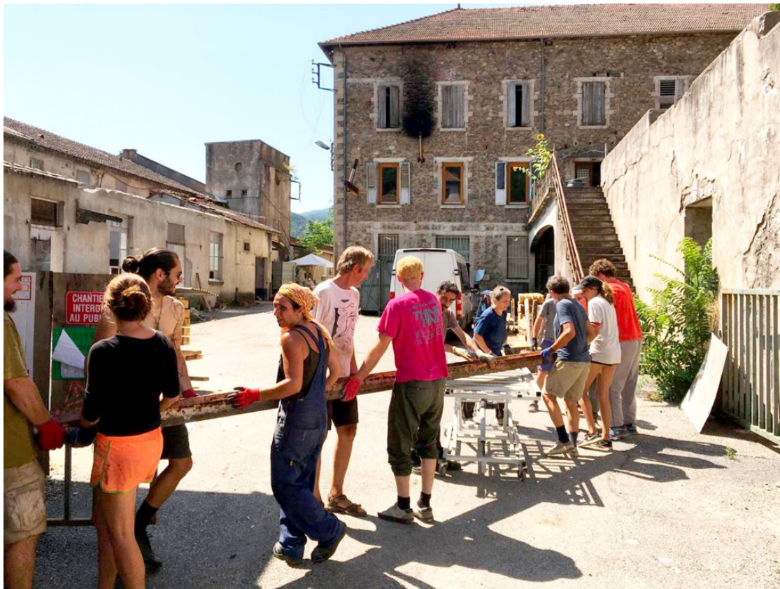
Le Moulinage en chantier : récupération des IPN du bâtiment, 2020 © Moulinage de Chirols
