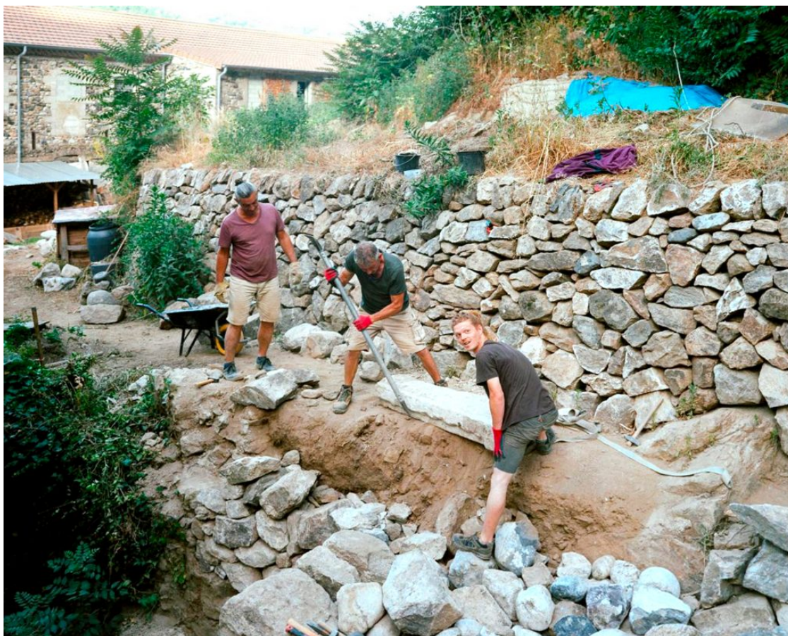
Le Moulinage de Chirols en chantier : le collectif à l'œuvre, 2022 © Lucien Lung
