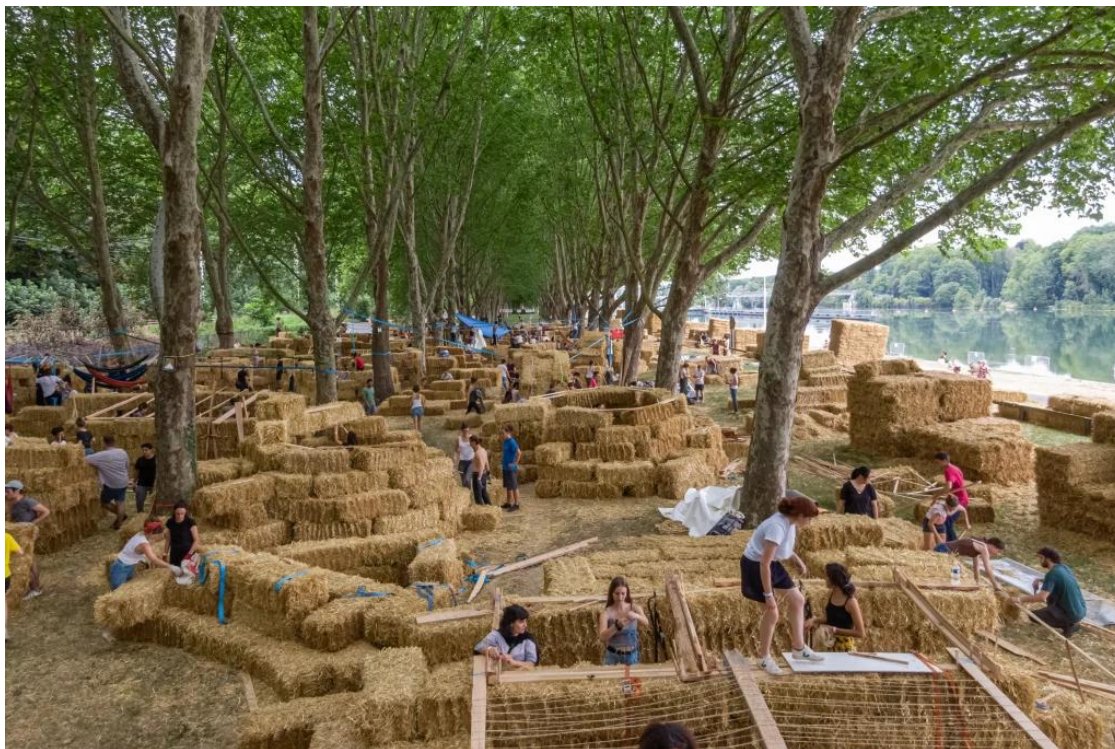
Festival Bellastock 2019 "Melting Botte", construction d'une ville éphémère à partir de bottes de paille, Évry-Courcouronnes. ©Alexis Leclercq
