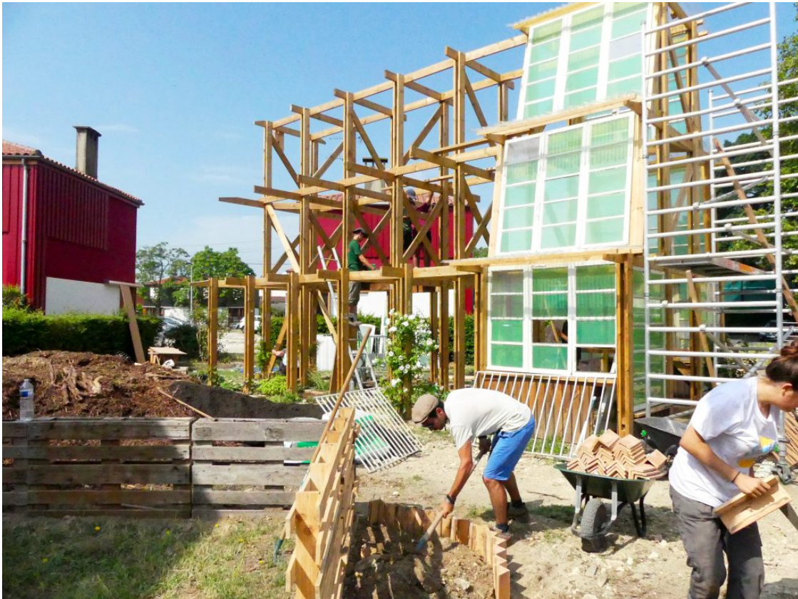
Chantier participatif d'une semaine pour bâtir une roseraie en remployant les anciennes fenêtres des maisons de Claveau désormais rénovées, 2019 © Agence Nicole Concordet
