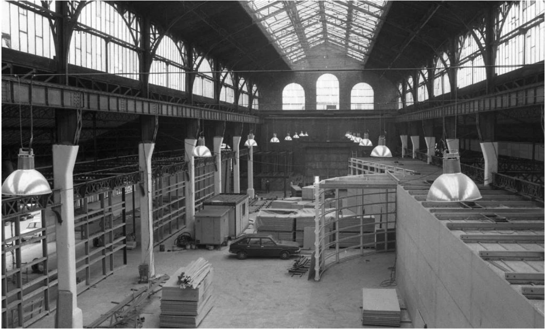
L'ossature du Magasin a été construite par Gustave Eiffel pour l'Exposition universelle de 1900.
