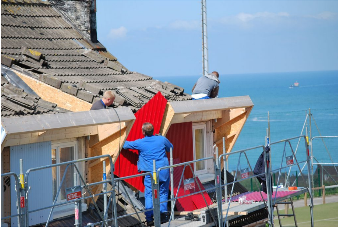
Les couvreurs sur les toits des maisons - couvertures et isolation des nouveaux haut-vents en charpente-bois en tôle ondulée métallique. Entreprises ESN Couverture et Charpente Cénomane © agence Construire
