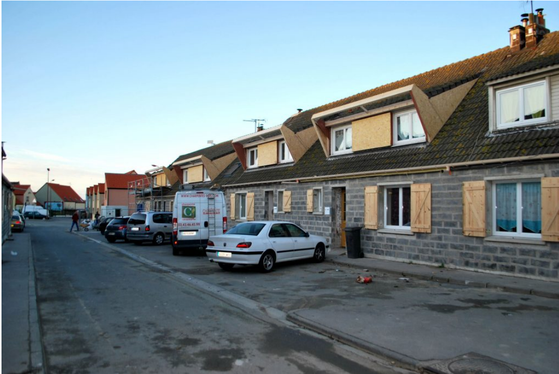
Les maisons recouvertes d'une double peau isolée par l'extérieur ; pose par l'extérieur de nouvelles menuiseries en saillie sur le nouvel encadrement béton ; mise en œuvre d'une nouvelle charpente protectrice des intempéries et isolation des belles-voisines. Entreprises SACOB Construction, Tellier menuiseries, Charpente Cénomane et Fumisterie © agence Construire
