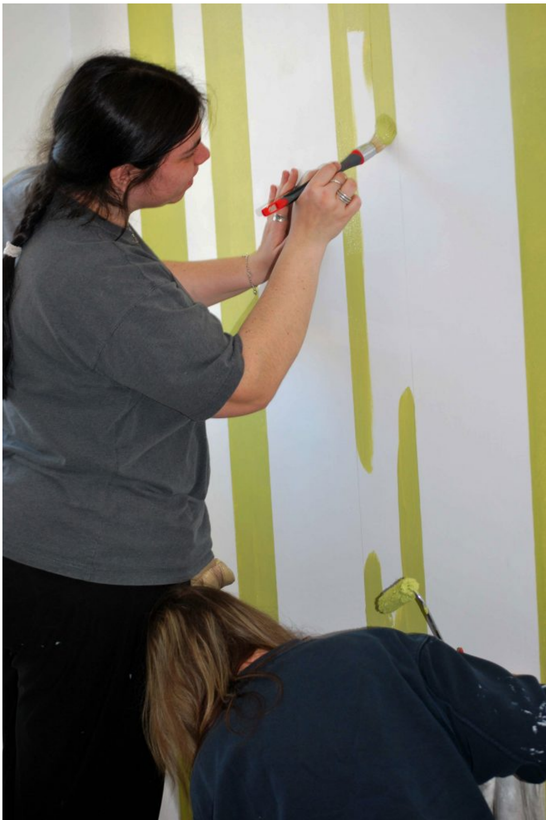
Les habitantEs en contrat de travail et d'apprentissage avec les associations d'insertion pour le chantier-école des peintures, faïences et papiers peints intérieurs des maisons. Associations CreActif et Rivages propres. © agence Construire
