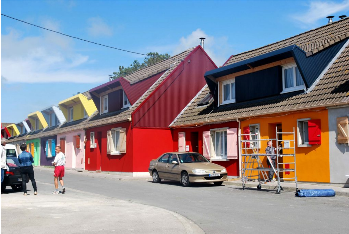
Les travaux intérieurs et extérieurs en cours de finition. Été 2012 © agence Construire
