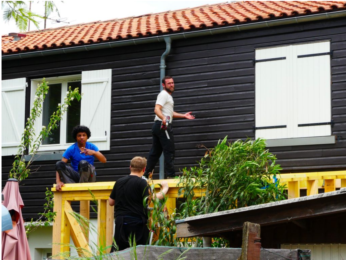
Chantier de réhabilitation des maisons de Claveau avec les Compagnons Bâisseurs, 2018 © Agence Nicole Concordet
