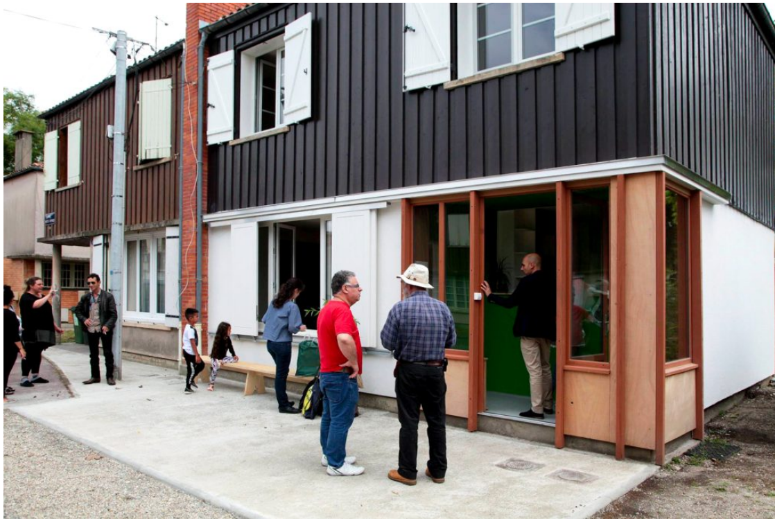
Des habitantEs de Claveau autour d'une maison réhabilitée avec son sas, ses nouvelles fenêtres et son nouveau bardage en façade. Le sas, un vestibule en bois sous le porche de chaque maison, comme une pièce en plus, 2018 © Agence Nicole Concordet
