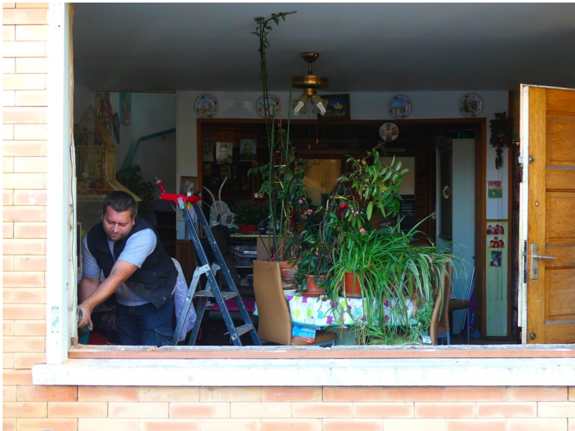
Travaux menés dans une des maisons de Claveau, 2016 © Agence Nicole Concordet
