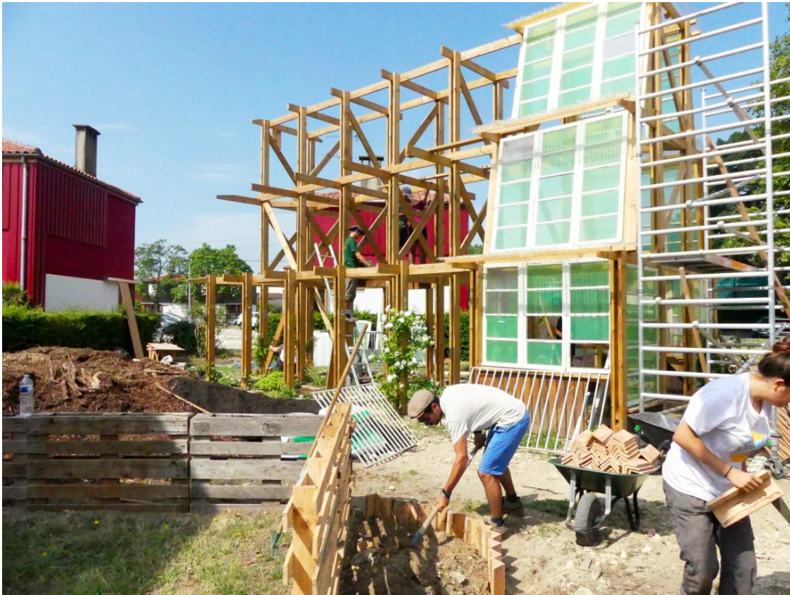
Chantier participatif d'une semaine pour bâtir une roseraie en remployant les anciennes fenêtres des maisons de Claveau désormais rénovées, 2019 © Agence Nicole Concordet
