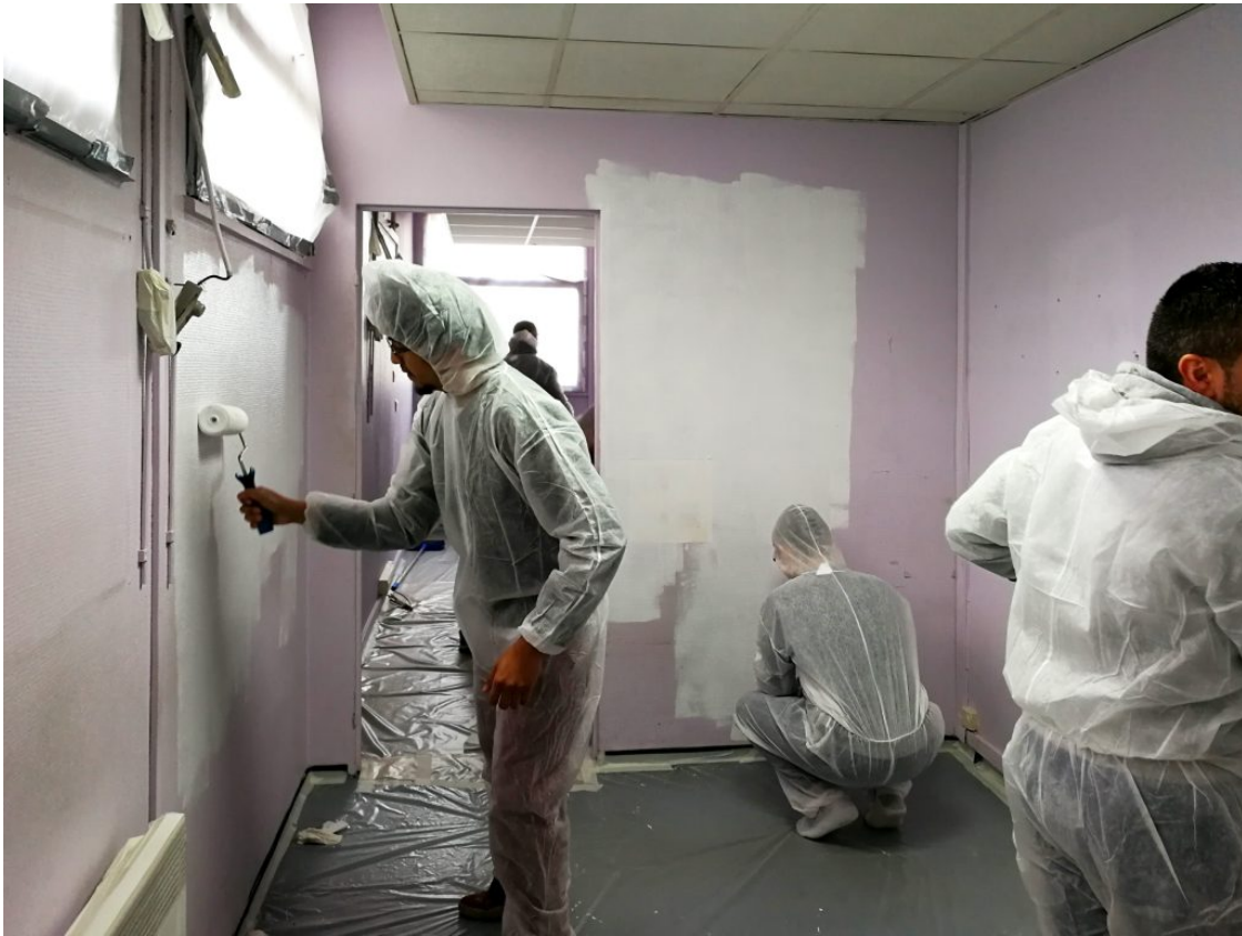
Chantier de la cuisine de Goussainville, 2018 © Association RER
