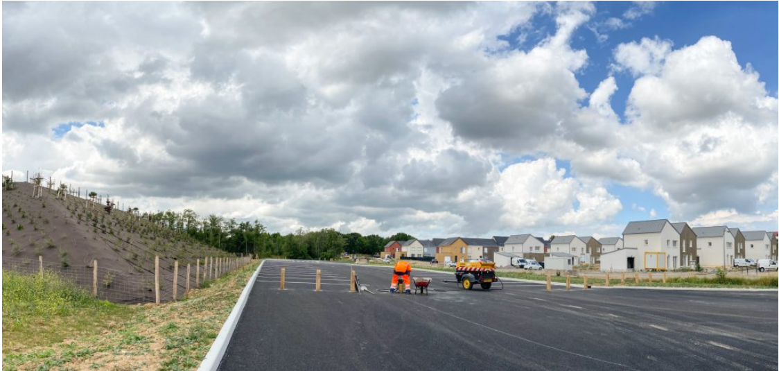
Chantier d'aménagement du parc des métallos, 2021 © Liliana Motta
