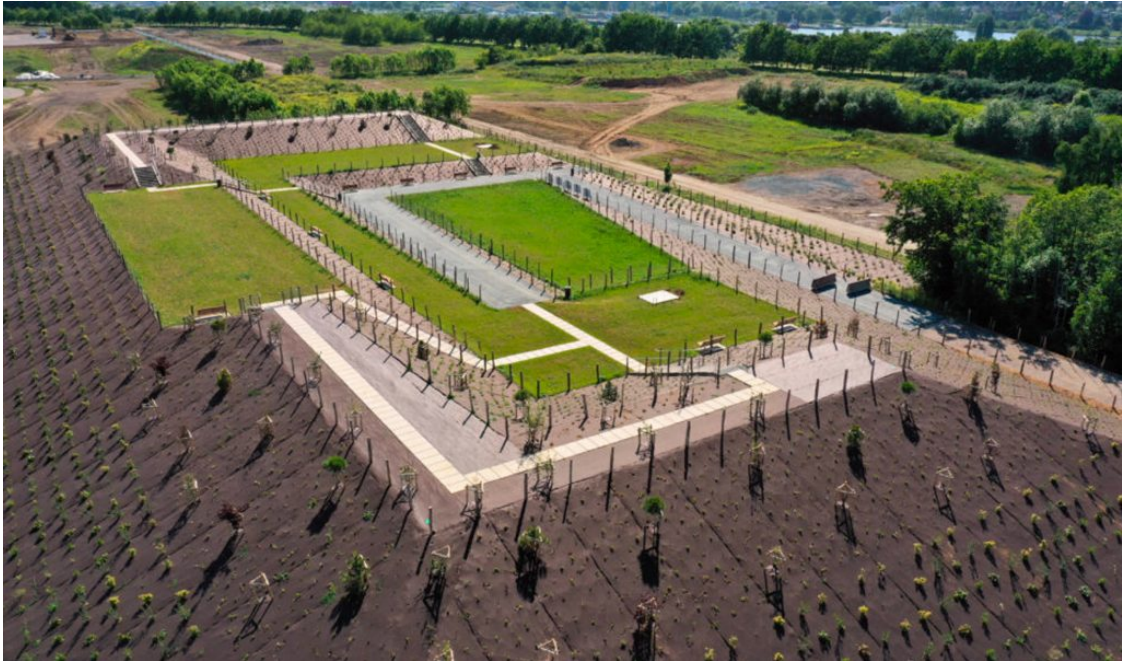
Chantier d'aménagement du parc des métallos, 2021 © Liliana Motta
