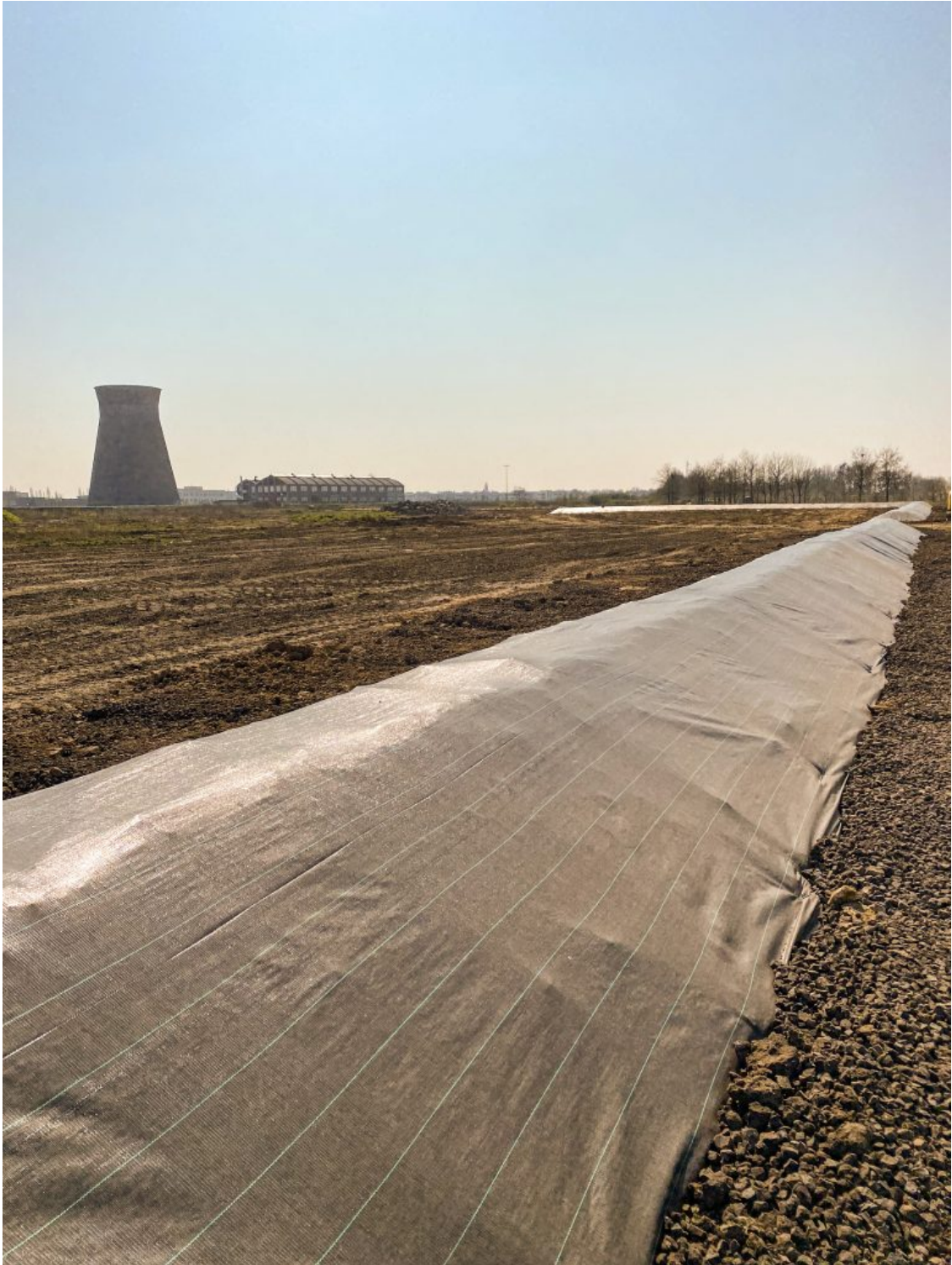
Chantier d'aménagement du parc des métallos. Au loin, le réfrigérant et la grande halle du WIP, 2021 © Liliana Motta
