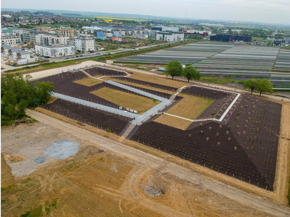
Chantier d'aménagement du parc des métallos, 2021 © Liliana Motta
