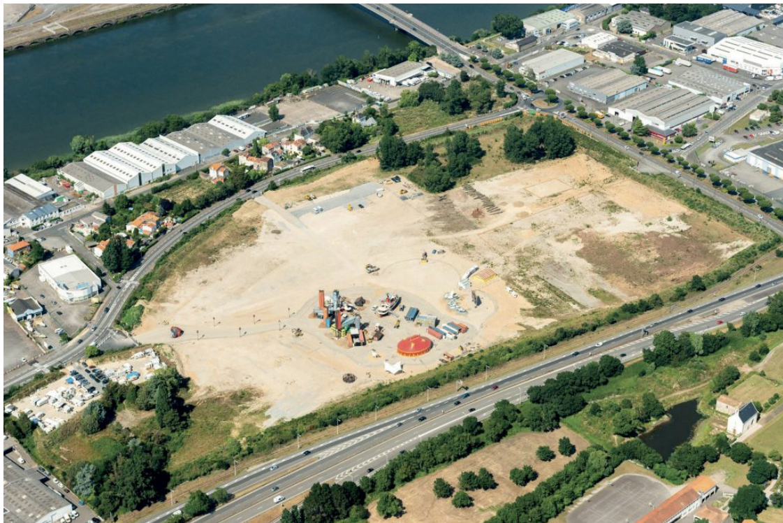
Les premières installations de Transfert, 2018 © Valéry Joncheray
