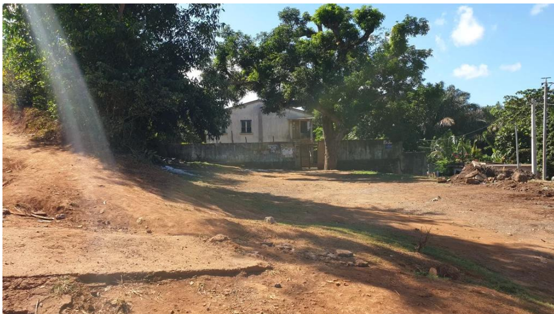
Le parvis de la MJC avant les travaux © La Preuve par 7
