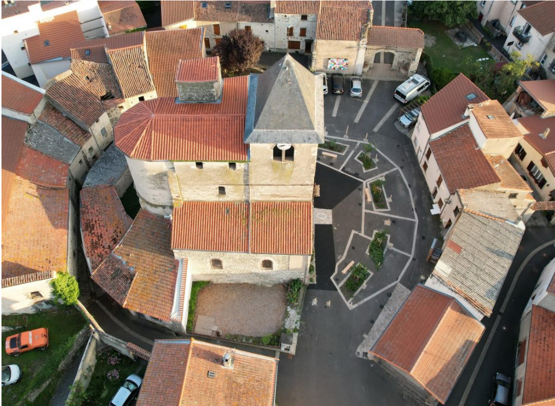
Le parvis de l'église, place Onslow, réaménagé. A la demande des habitantEs, le tracé de l'ancien fort est matérialisé au sol par des pavés
