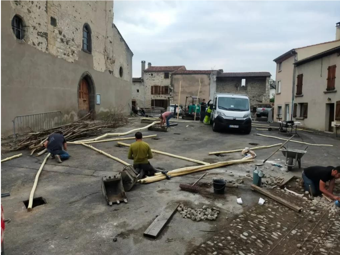
Chantier du "Village en chantier" sur la place Onslow, 2020
