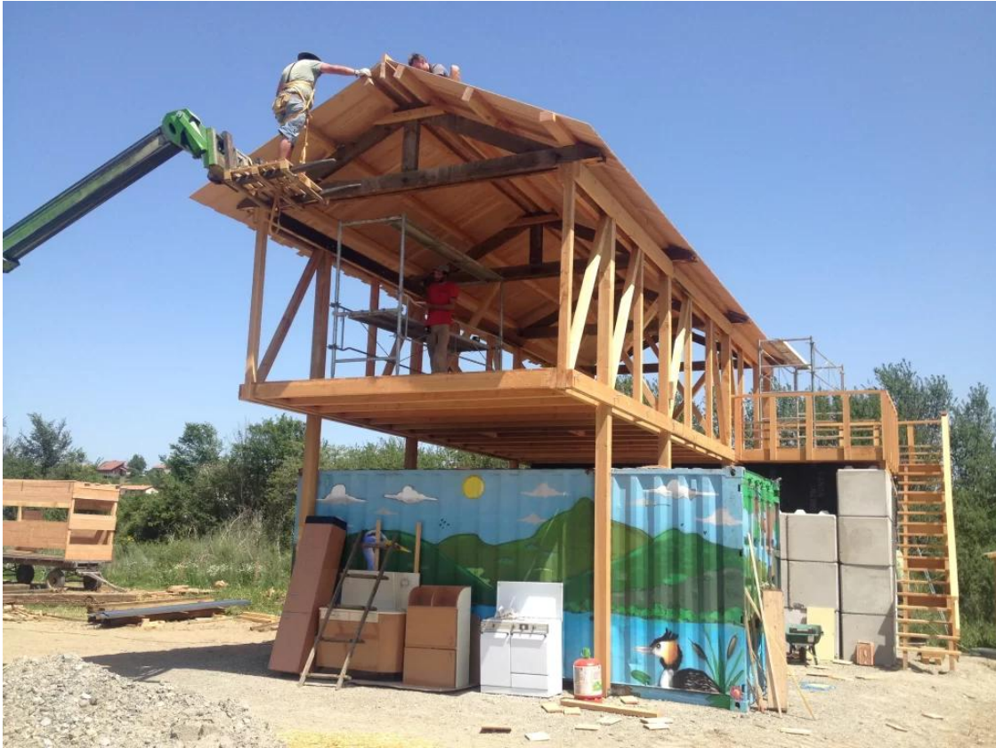
Chantier du hangar agricole, 2020
