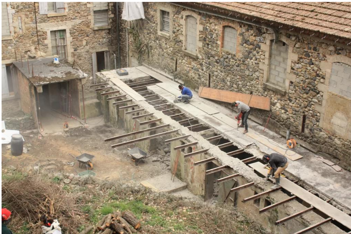
Démolition du bâtiment de construction récente qui obérait la « rue » © Le Moulinage de Chirols
