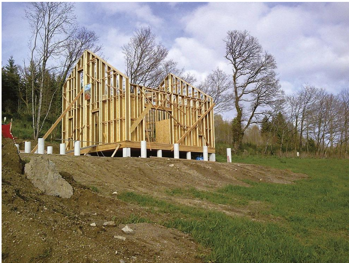
Chantier du logement passerelle de Faux-la-Montagne, 2014.
