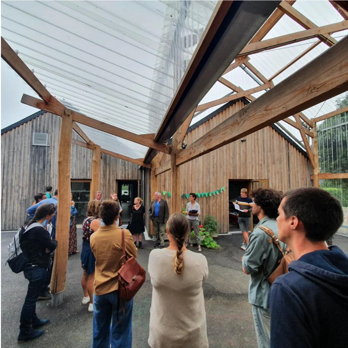
Visite de l'école réhabilitée et agrandie de la petite commune de Mouais (400 habitantEs) en Loire-Atlantique : réalisation avec des matériaux du territoire, bois, paille, terre en écho à l'identité de la commune, et démarche mise en place pour le pilotage du projet, 2022 © BRUDED
