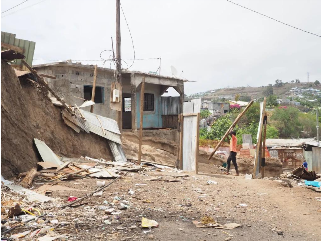
Chantier de résorption de l'habitat insalubre à Majicavo © Harappa
