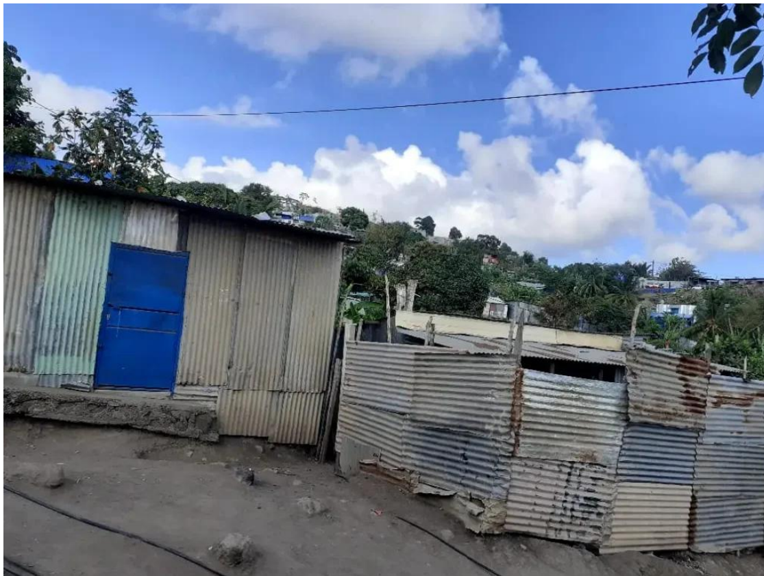
Habitat insalubre dans un quartier de Koungou © Harappa
