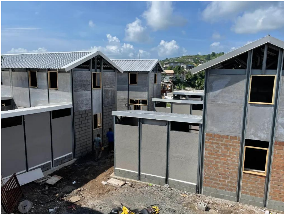
Construction des maisons © Harappa
