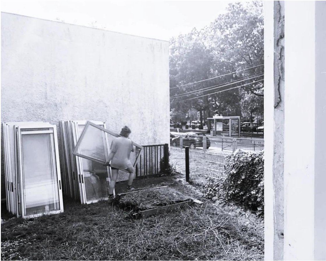
Un chantier de réemploi
