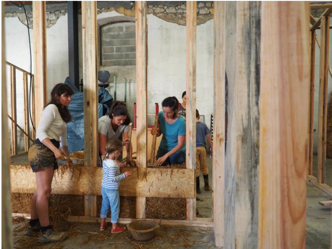
Ateliers ouverts à tous de construction de murs en terre paille, octobre-novembre 2023
