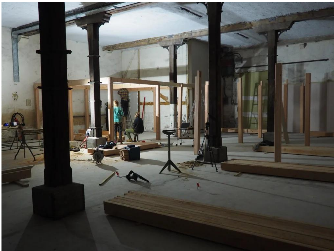
Chantier de construction de la maison de santé
