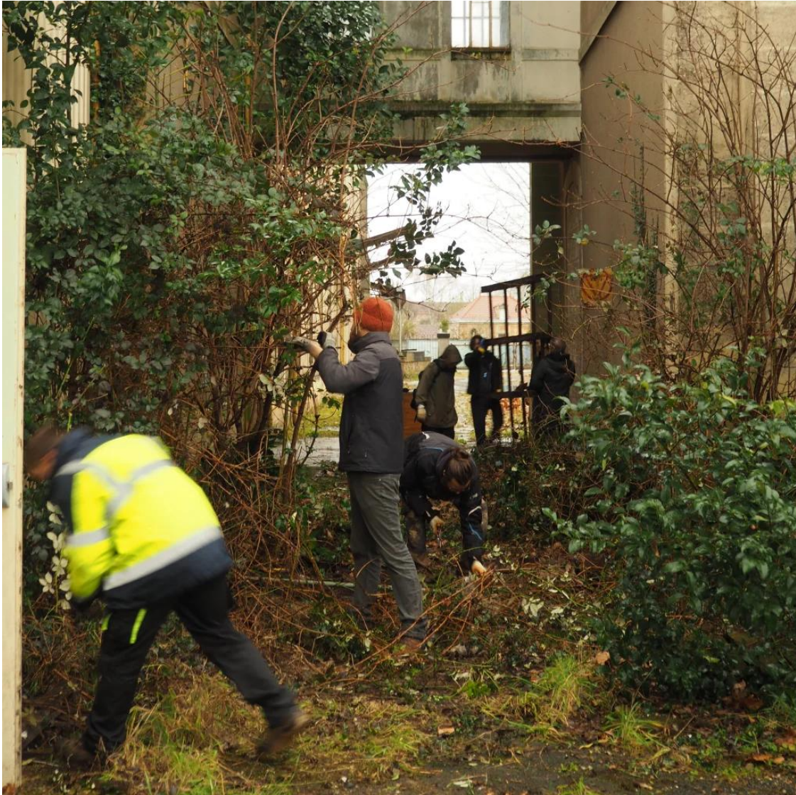
Le chantier de La Traverse
