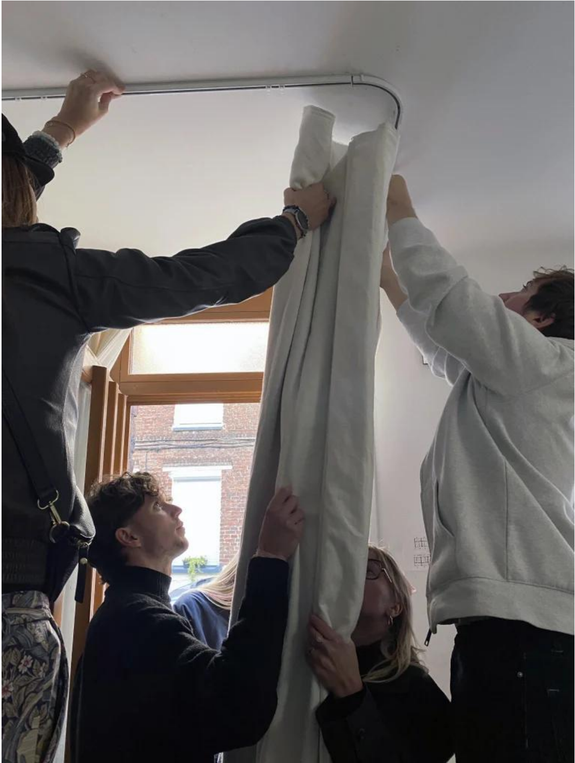
Installation d'un rideau thermique dans une maison de la cité d'Orient © Martin Fessard
