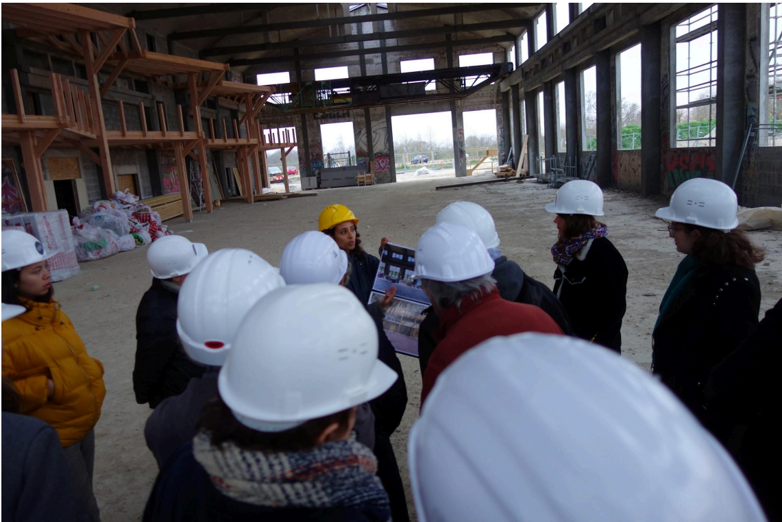
Le chantier ouvert - la grande halle de Caen
